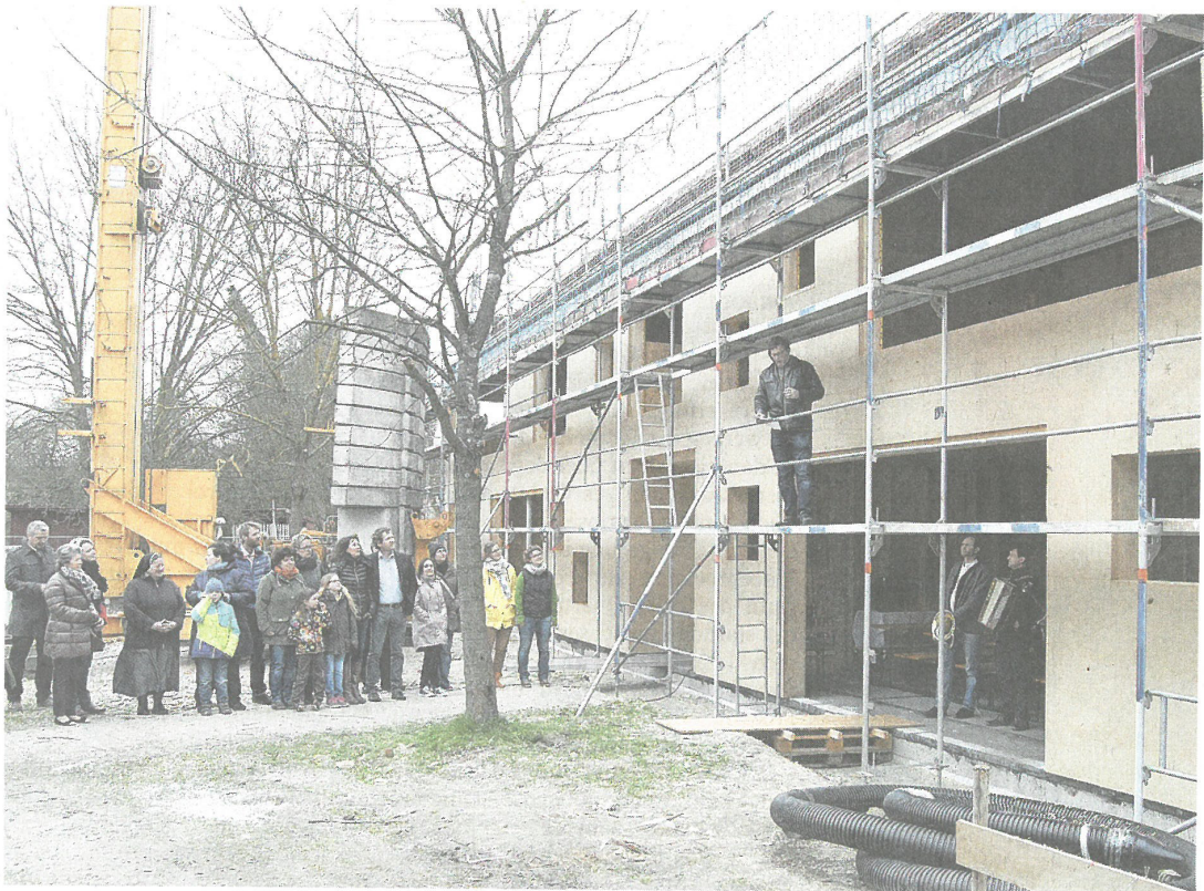
Architekt Andreas Schleich übernahm beim Richtfestspruch den Part der Zimmermänner.
